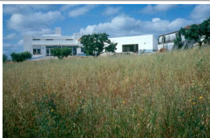
Vista geral de sul
