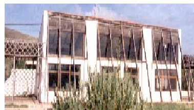
Figure 12. Solar House (Porto Santo-Madeira)
